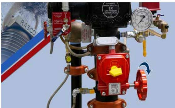
Das Wasserhauptsteuerventil langsam öffnen. Überprüfen, ob das Steuerventil vollständig geöffnet ist und ordnungsgemäß überwacht wird.
