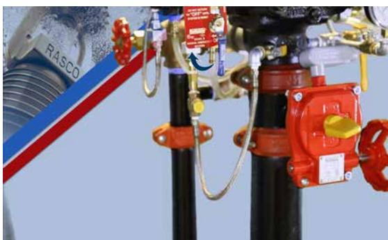
Wenn die Wassermenge, die durch die Handnotauslösung fließt, ein einheitliches Maß erreicht hat, das Handnotauslösungsventil schließen.
