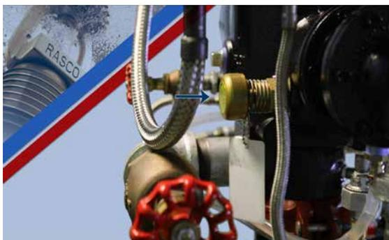
Den Reset-Knopf drücken und von der Vorderseite des Ventils Modell EX aus gesehen gegen den Uhrzeigersinn drehen, bis die Ventildeckelklappe auslöst und sich vollständig senkt.
