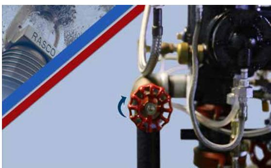
Die Hauptentleerung langsam schließen bis Wasser durch die Entleerungsleitung der Handnotauslösung auszutreten beginnt.
