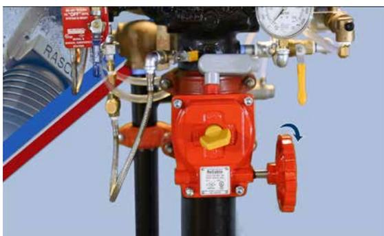
Bei vollständig geöffnetem Handnotauslösungsventil und teilweise geöffnetem Hauptentleerungsventil langsam das Wasserhauptsteuerventil öffnen, bis zu hören ist, dass Wasser durch die Hauptentleerung fließt.
