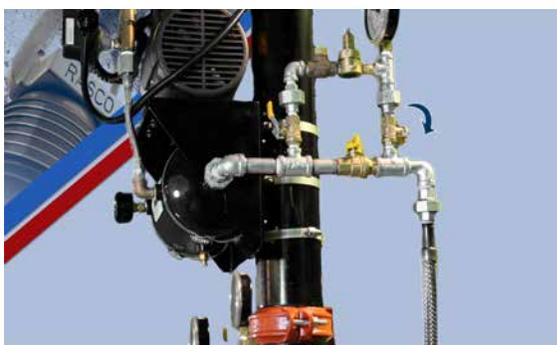
Das Luft- bzw. Stickstoffversorgungsventil öffnen und Druck in der Anlage aufbauen bis das Manometer den angegebenen Anlagenmindestdruck anzeigt. Anlagenmindestdruck, siehe Tabelle F. Die Luft- bzw. Stickstoffquelle in automatischen Betrieb versetzen.
