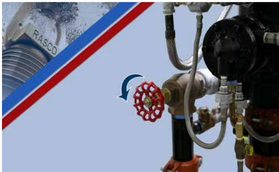
Das Hauptentleerungsventil zwei Umdrehungen weit öffnen. Nun das Wasserhauptsteuerventil teilweise öffnen, bis Wasser durch die Hauptentleerung fließt.
