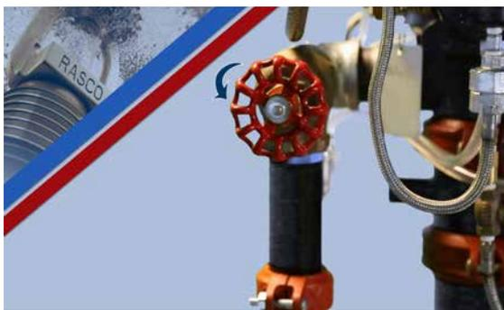
Das Hauptentleerungsventil öffnen und die Anlage vollständig entleeren.
