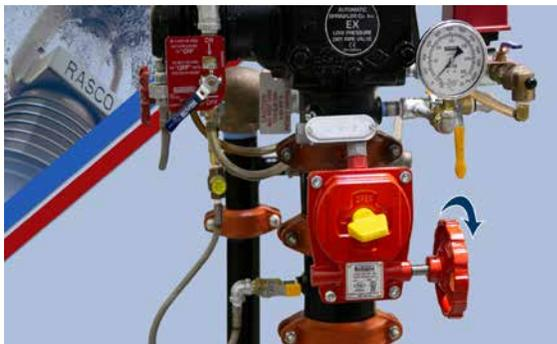
Abra lentamente la válvula principal de control de agua. Compruebe que la válvula principal está completamente abierta y correctamente supervisada.
