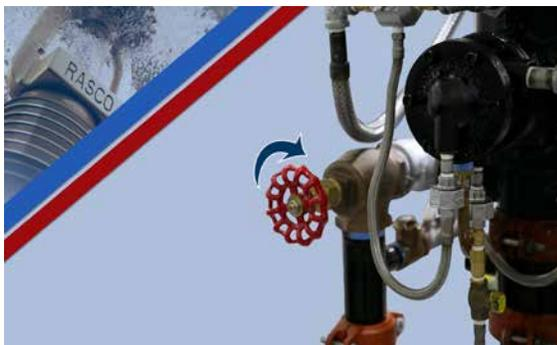
Cierre lentamente la válvula de drenaje principal hasta que quede completamente cerrada.
