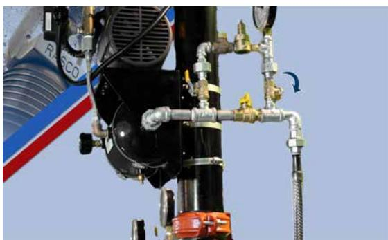
Abra la válvula de suministro de aire o nitrógeno y presurice el sistema hasta que el manómetro de presión del sistema alcance la presión mínima especificada para la instalación. Para conocer la presión mínima para su sistema, consulte la Tabla F. Luego configure la fuente de aire o nitrógeno para su funcionamiento automático.
