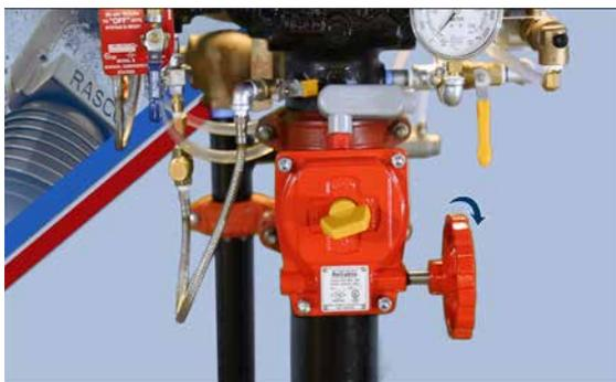
Con la válvula de disparo manual de emergencia completamente abierta y la válvula de drenaje principal parcialmente abierta, abra lentamente la válvula principal de control de agua hasta que se escuche el sonido de agua que sale del drenaje principal.
