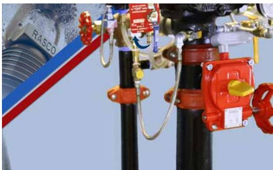
Cuando ya se alcance un caudal constante de agua a través del disparo manual de emergencia, cierre la Válvula del disparo manual de emergencia.
