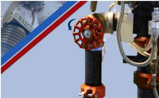
Abra la válvula de drenaje principal y vacíe completamente el sistema.
