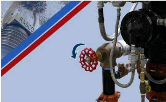
Abra la válvula de drenaje principal girándola dos vueltas. A continuación cierre la válvula principal de control de agua hasta que salga agua del drenaje principal..
