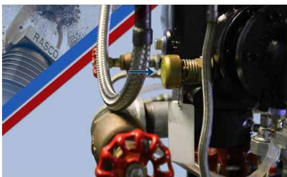
Empuje hacia dentro la perilla de rearme en sentido antihorario según se ve desde la parte delantera de la válvula EX hasta que la clapeta se libere y vuelva a su posición inicial.
