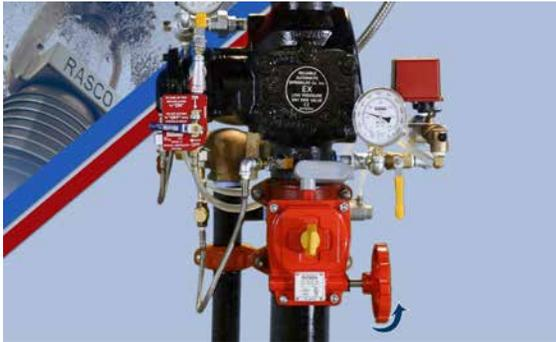
Cierre la válvula principal de control de agua y la válvula de suministro de la cámara de la varilla de empuje.
