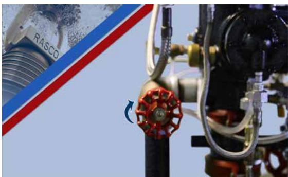
Fermer lentement la vidange principale et arrêter lorsque l'eau commence à s'écouler par la conduite de vidange de déclenchement manuel d'urgence.
