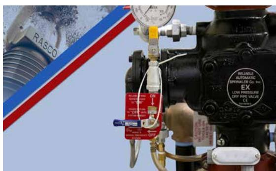
Fixer la poignée de la vanne de déclenchement manuel d'urgence, en position fermée par le biais de l'attache de câbles fournie avec les accessoires. Vérifier que toutes les vannes se trouvent dans la position correcte comme indiqué à la page 10.
