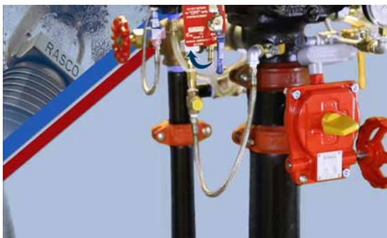
Une fois qu'un débit constant d'eau s'écoule par le dispositif manuel de déclenchement d'urgence, fermer la vanne de déclenchement manuel d'urgence.
