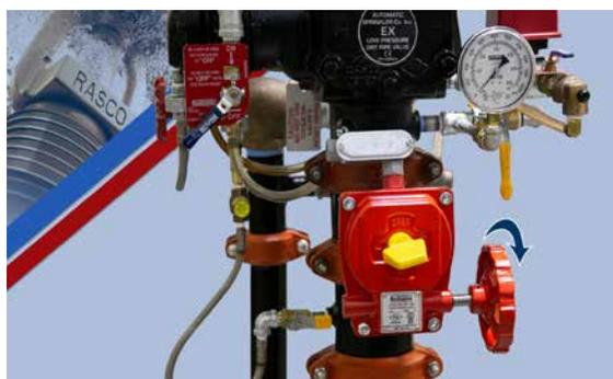
Ouvrir lentement la vanne principale d'arrêt de l'eau. Vérifier que la vanne principale est complètement ouverte et correctement surveillée.
