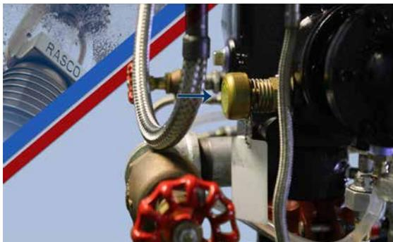
Appuyer sur le bouton de réarmement et le faire tourner dans le sens inverse des aiguilles d'une montre, (vue de l'avant de la vanne EX), jusqu'à ce que le clapet se libère et revienne à sa position initiale.
