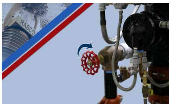
Fermer lentement la vanne de vidange principale jusqu'à sa fermeture totale.
