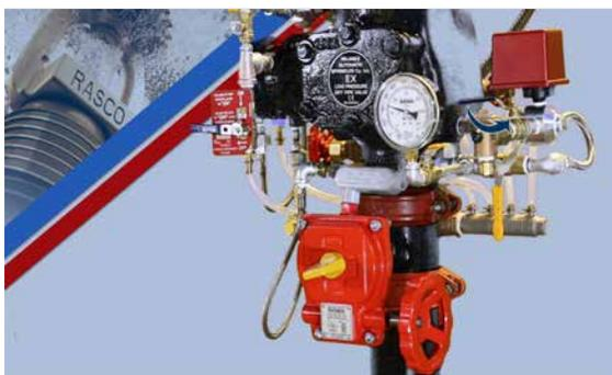
Ouvrir la vanne de conduite d'alarme. Noter que l'eau peut initialement s'écouler de la vanne de vidange à bille, mais cela cessera si le clapet est correctement scellé.
