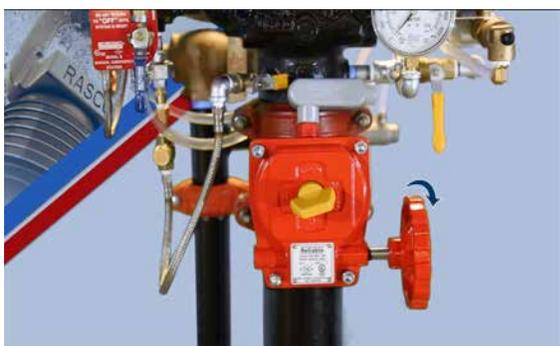
Lorsque la vanne de déclenchement manuel d'urgence est complètement ouverte et que la vanne de vidange principale est partiellement ouverte, ouvrir lentement la vanne d'arrêt principale jusqu'à ce que l'on commence à entendre de l'eau s'écouler par la vidange principale.
