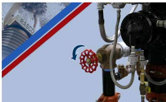
Tourner deux fois la vanne de vidange principale pour l'ouvrir. Ouvrir ensuite partiellement la vanne principale d'arrêt de l'eau jusqu'à ce que l'eau s'écoule par la vidange principale.
